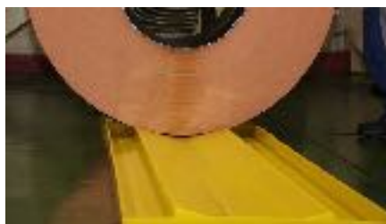
Esterilla de bobinas con bandeja recolectora de aceite perimetral
